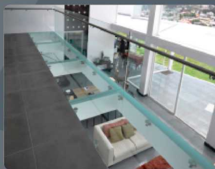
Puente en Vidrio
